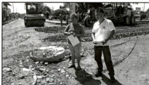
Calle en construcción
