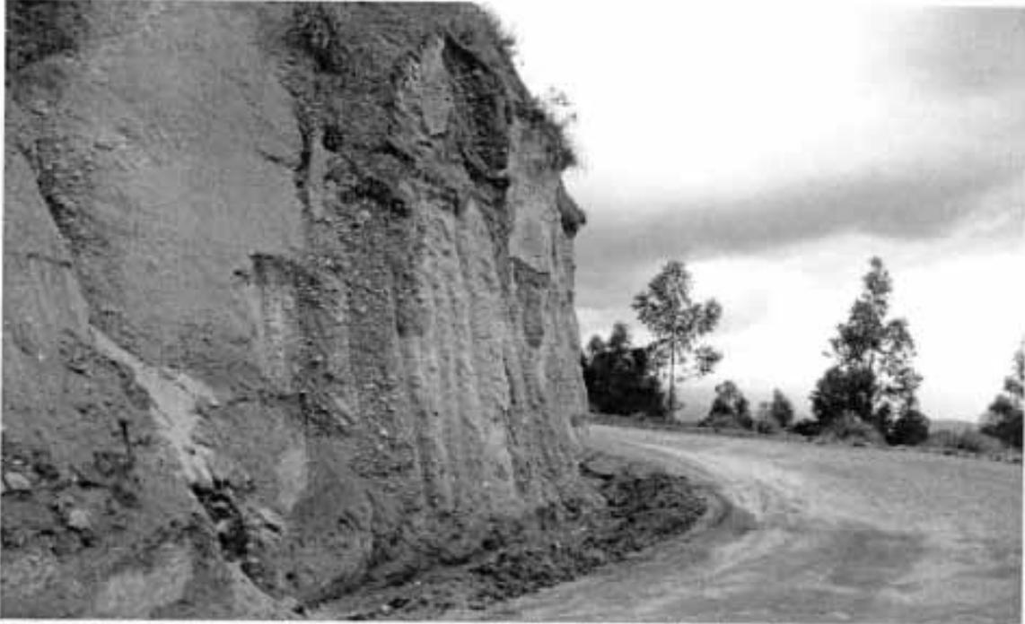
Se recomienda que se deba aumentar un talud en la mitad de la peña para no ocasionar derrumbes, ya que la tierra es blanca con cascajos, y se observa que con un mínimo movimiento se desliza la tierra, de ser posible el operador pluma debe realizar un trabajo con corte de 45% de pendiente en tipo "V"
