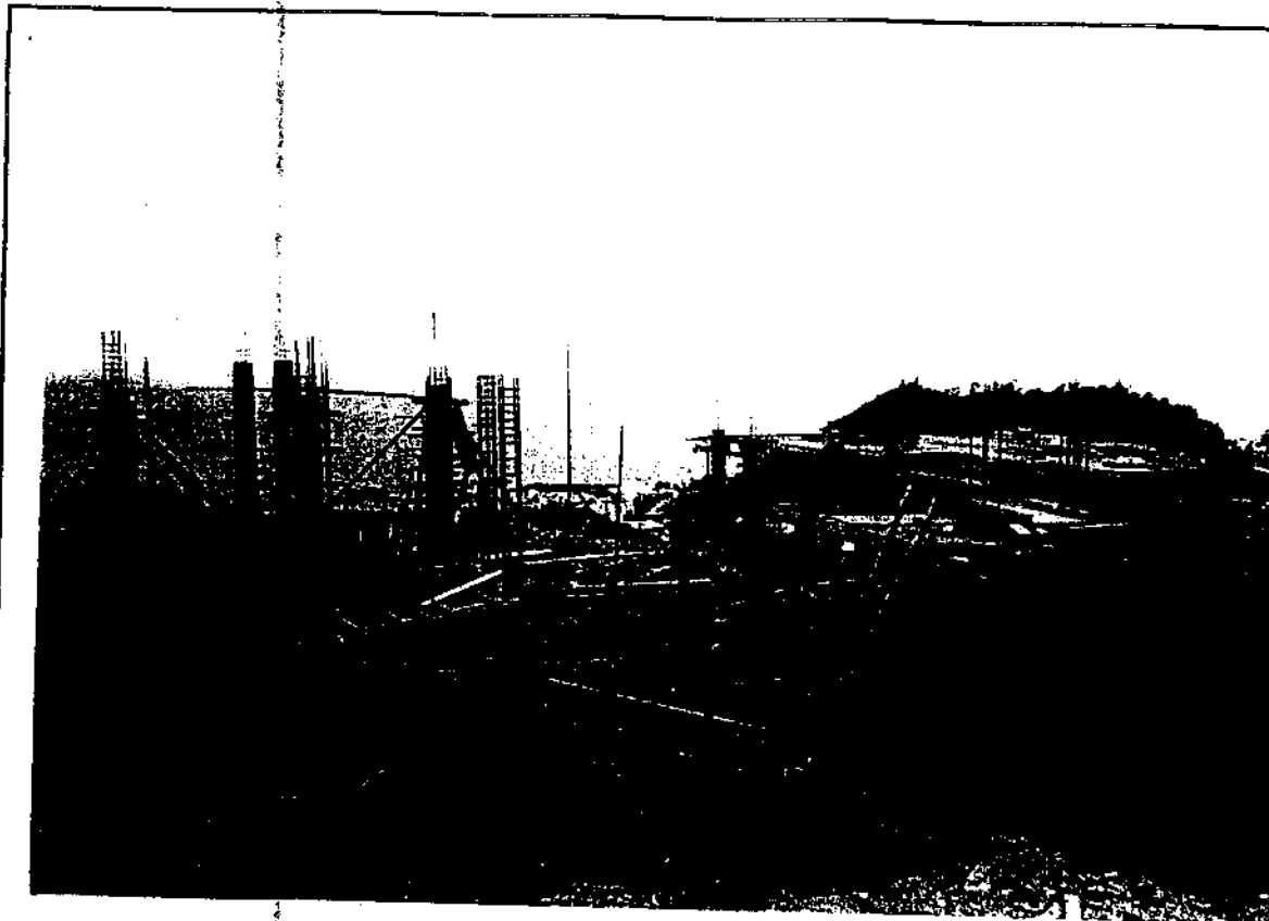
Fotografía # 18.- Construcciones en el lindero medianero con el Lote 2.
