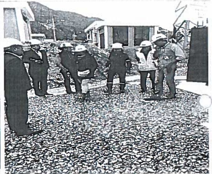
FOTOGRAFÍA 3: Reunión in situ , Equipo veedor, funcionarios de EP Petroecuador y CPCS Estación de Bombeo Charcay, Juncal-Cañar
