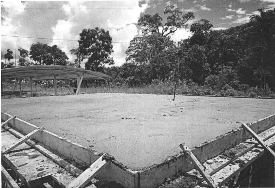
Terraza o losa de la batería sanitaria fundida con hormigón
