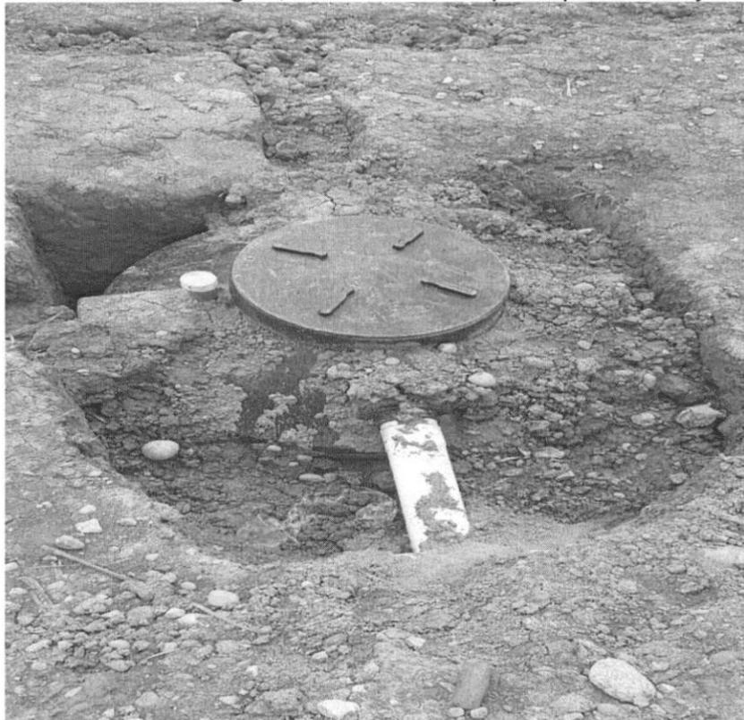
Tanque biodigestor (Tratamiento aguas servidas)
