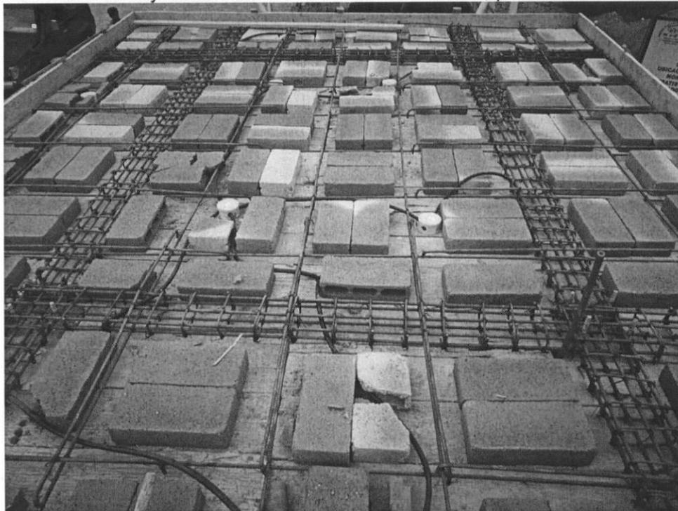
Armado de hierro en la terraza o losa de la batería sanitaria para fundir con hormigón
