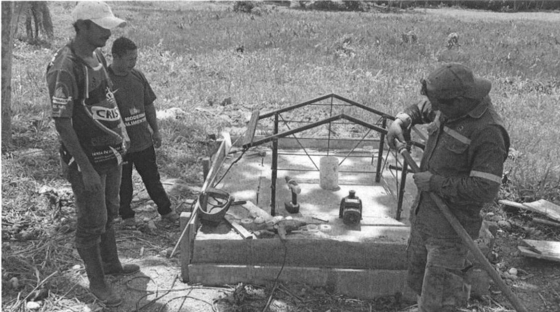
Colocación de tubería red de agua, conexión entre pozo perforado y batería sanitaria
