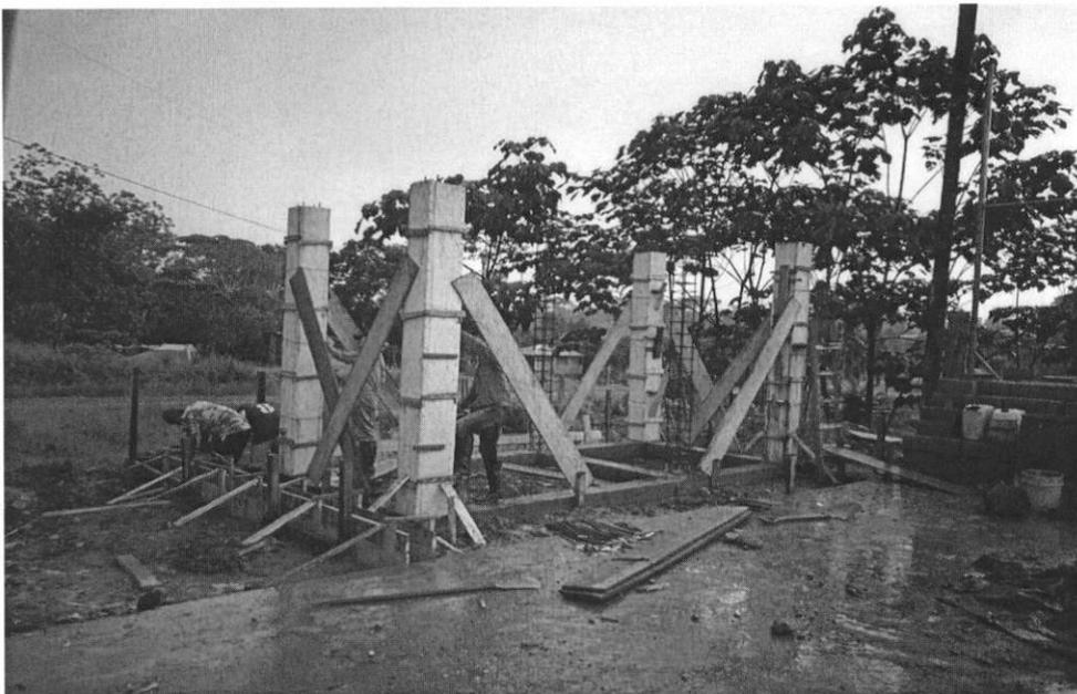
Encofrado de muros y columnas de la batería sanitaria, para fundir con hormigón
