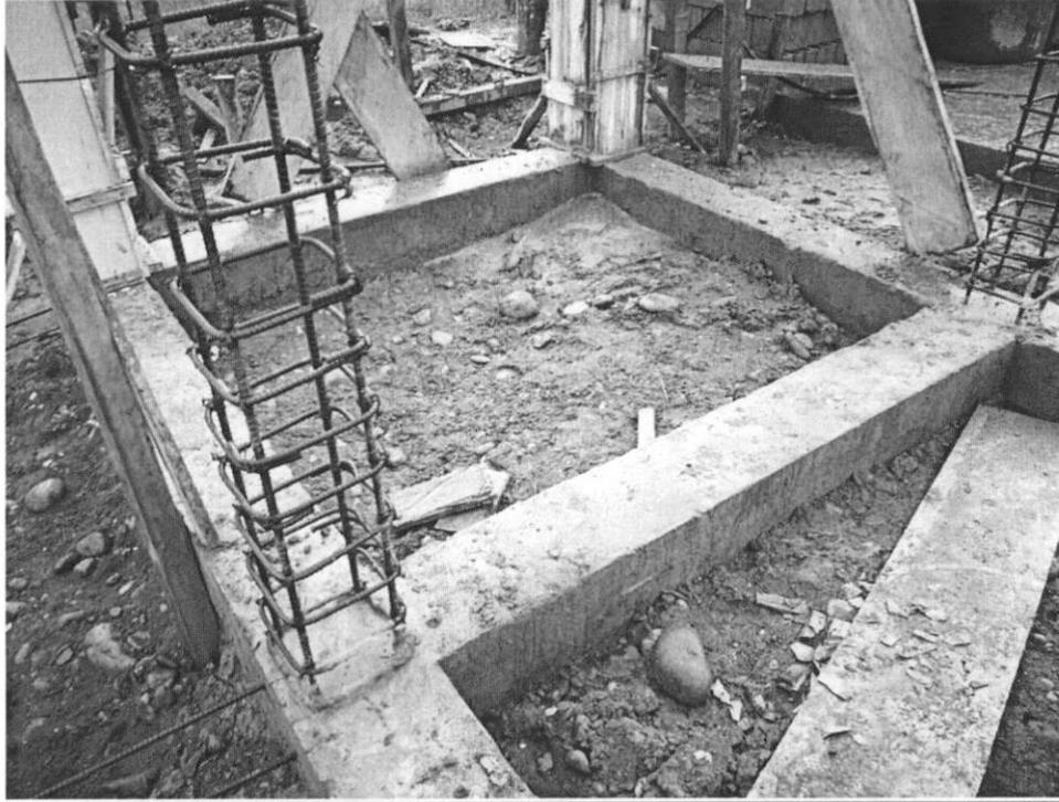
Armado de columnas con hierro de la batería sanitaria
